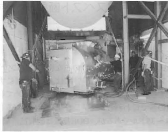
図2 32トンの焼却炉を移動するために使われたエアキャスタ
