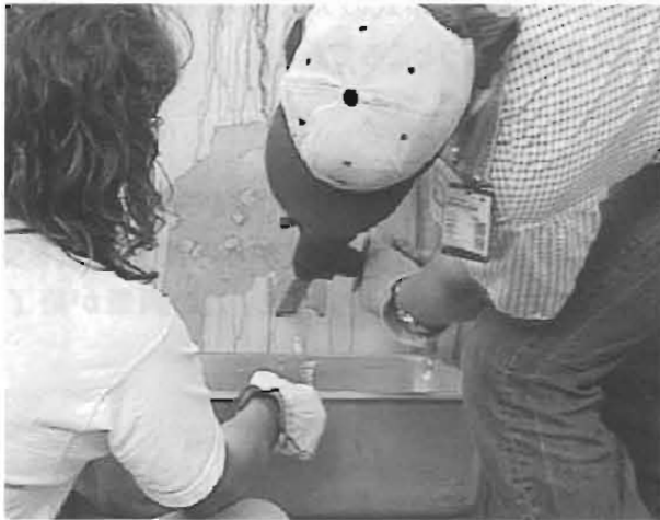
図3 ポッシュ製回転ハンマードリルによる塗料の特性調査作業
